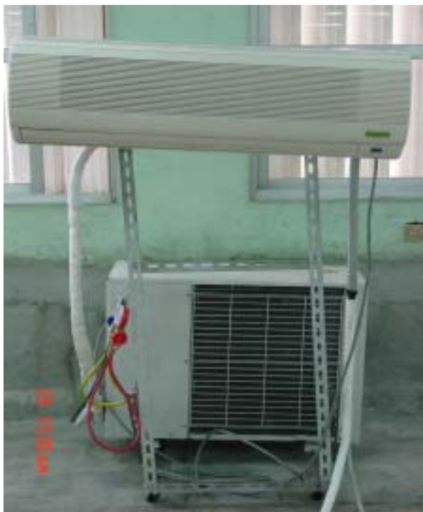
分離式冷氣機
